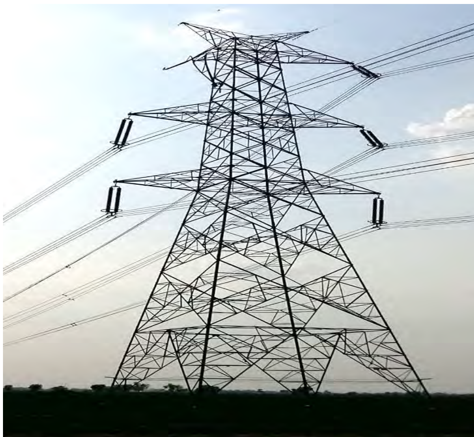
Tower loc. No. 546 (DA+0)
