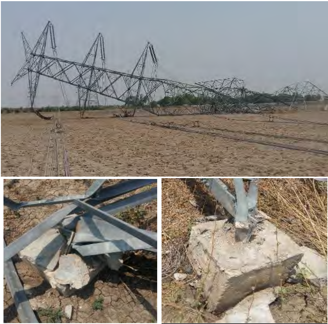
Tower loc. No. 552 (DA+9)
