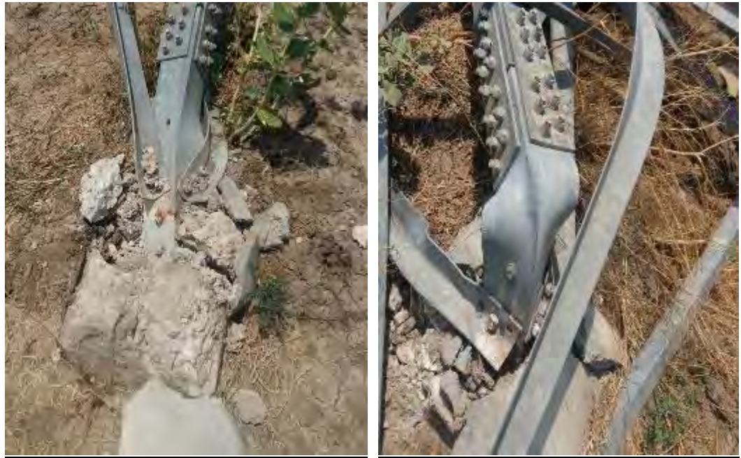
Tower loc. No. 551 (DA+0)
