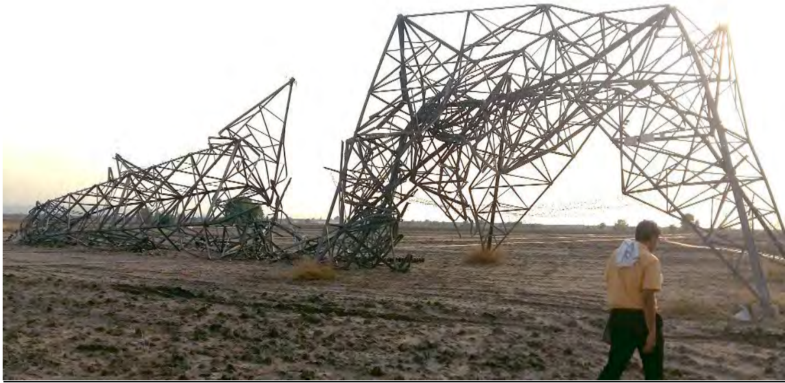
Tower loc. No. 550 (DA+0)
