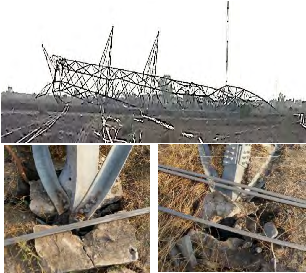
Tower loc. No. 548 (DA+0)
